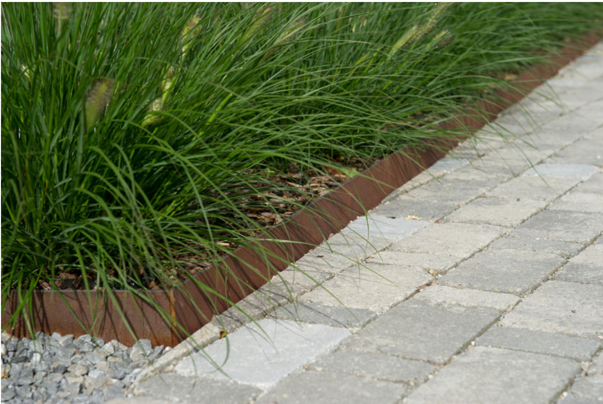
Stahlbandeinfassung | Garten L. in W.
