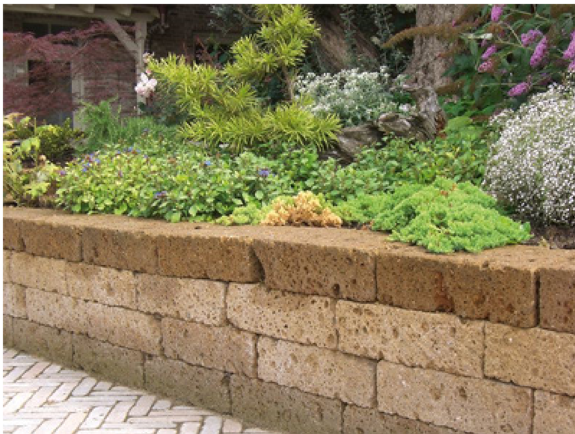
Tuffsteinmauer
