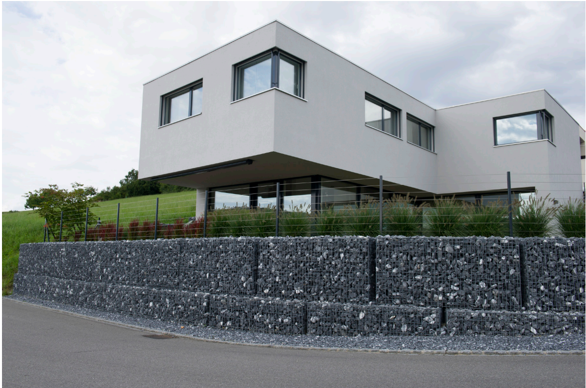
Drahtschotterkörbe gefüllt mit Kies gebrochen 80/120 sw
