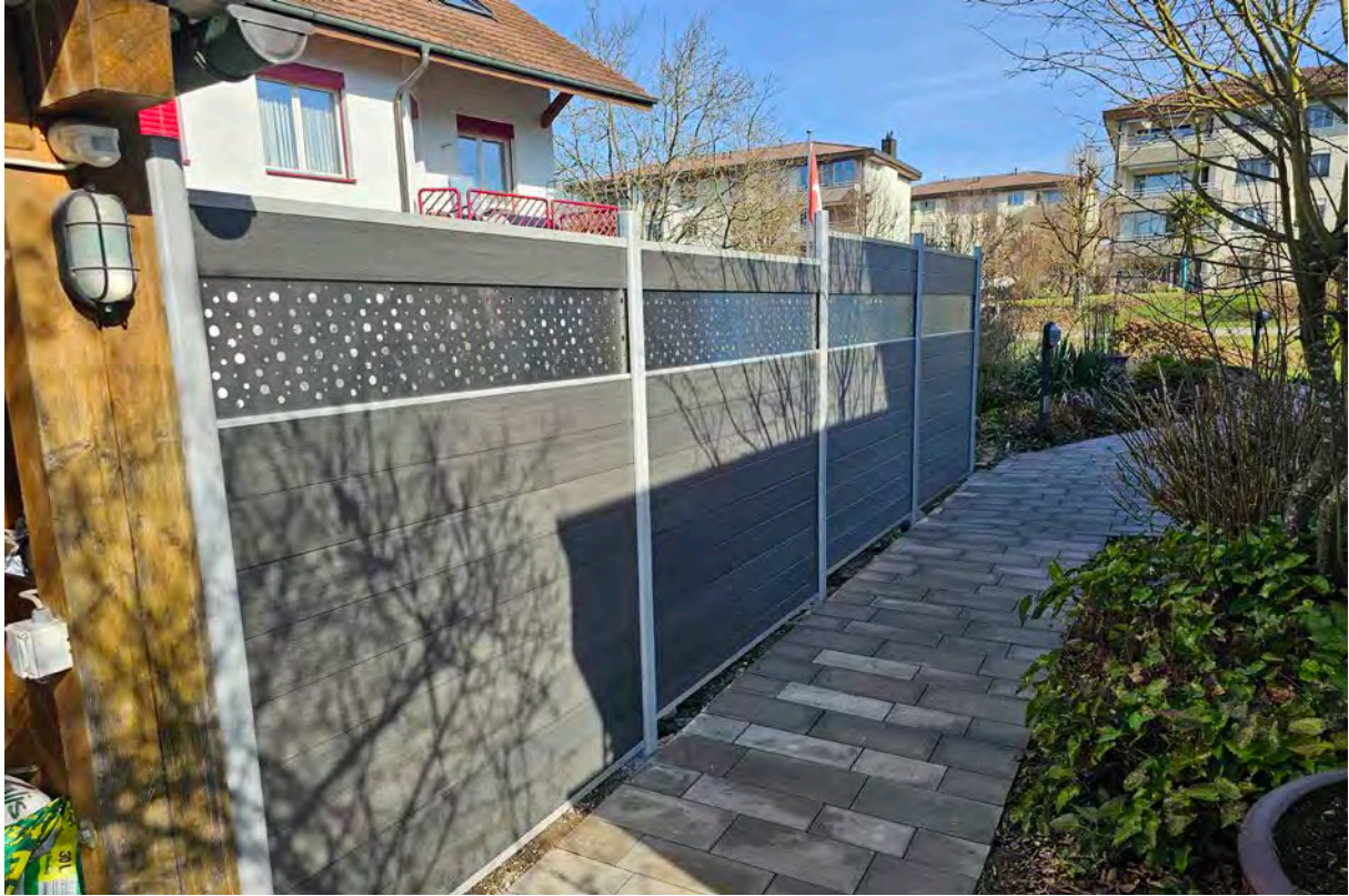
WPC (Wood-Plastic-Composit) mit Stahlblech Füllung
